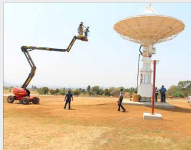
Figure 46: New Viasat RTE Site
